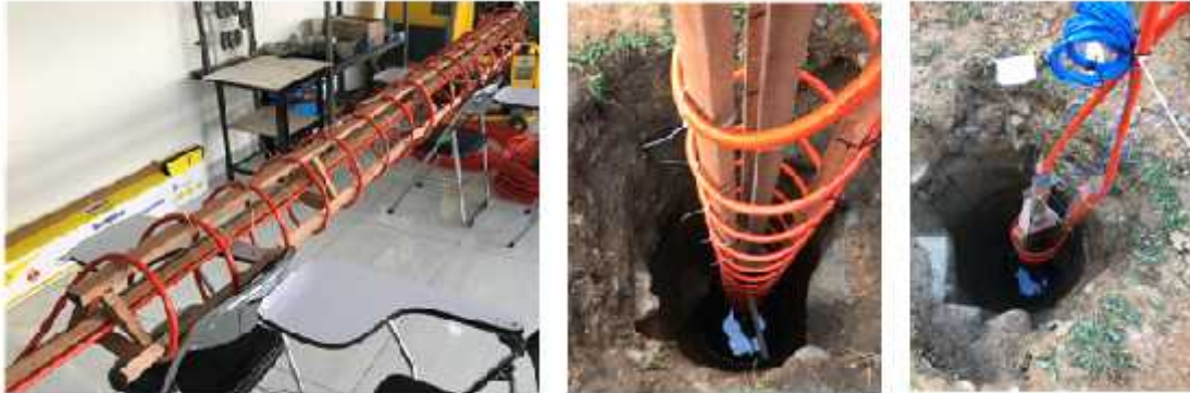
Fig. 1. Spiral-tube GHE.
